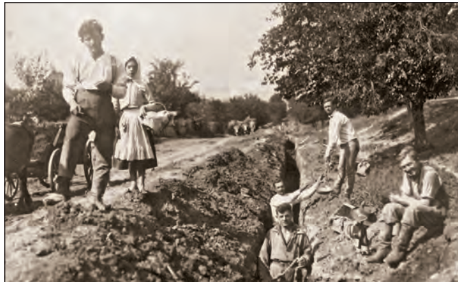
Velkým pomocníkom pre staranských hasičov bol od roku 1927 miestny vodovod s hydrantami rozmiestnenými na viacerých miestach v obci. Snímka z rodinného archívu Kunderových je z výstavby tohto diela v rokoch 1926 – 1927.
