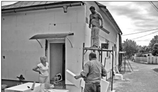
V Zbudzi zateplili budovu Kultúrneho domu.
